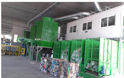
Impianto di selezione Piattaforma Eco.Lan. s.p.a.
